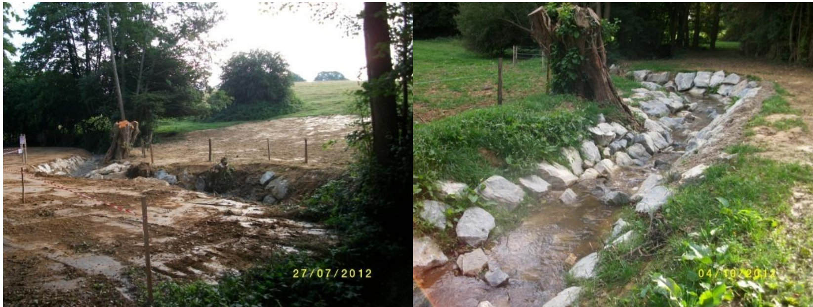
Figure 2. Etat final : vue du ruisseau depuis l'aval (à g) et vue de détail du lit depuis l'amont (à d).
