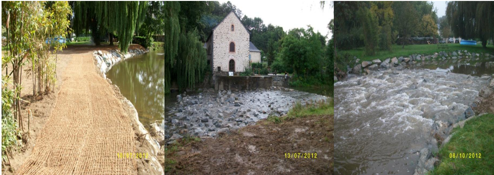
Figure 10. Vue de la berge rive droite enrochée et fixée par la bâche coco, avant ensemencement (à g), vue du seuil du bourg allongé (au c.) et vue du seuil amont en gros blocs (refait en octobre 2012 à la suite de la crue du 27 juillet 2012).
