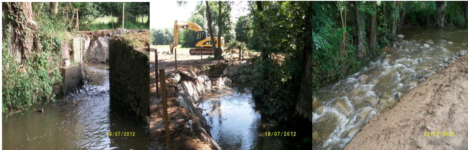
Figure 15. Vue du batardeau après travaux (à g.), vue de la berge enrochée en amont (au c.) et vue de la rampe en aval du batardeau (à d.)
