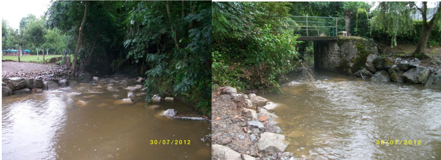
Figure 17. Vue de la rampe en aval de la passerelle après travaux (à g.) et vue de la passerelle et de son radier ennoyé (à d.)
