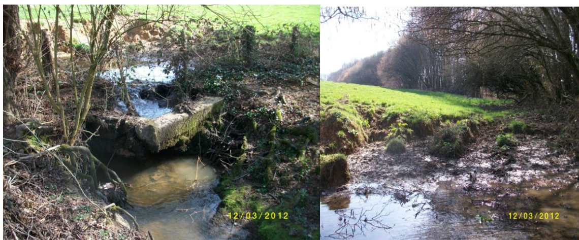
Figure 1. Etat initial : vue de l'ancien bac béton et vue de la zone dégradée en amont (en rive gauche)
