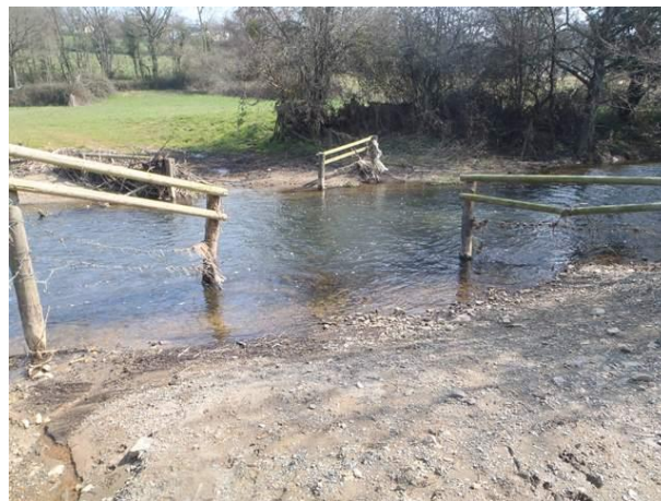
Passage à gué aménagé sur le Vicoin au Genest-Saint-Isle
