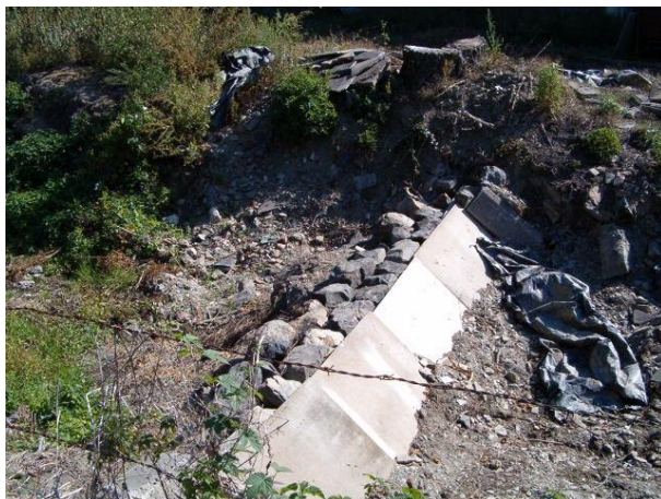
Seuil béton avant travaux
