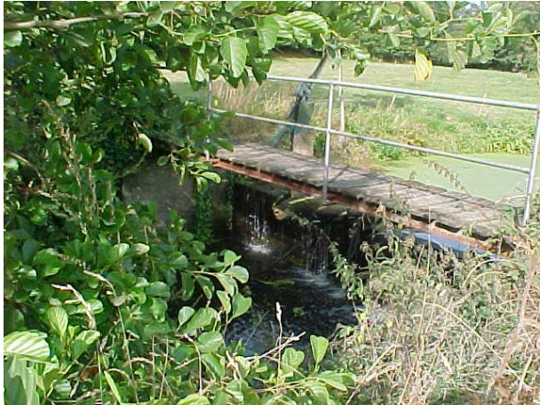
Clapet avant travaux
