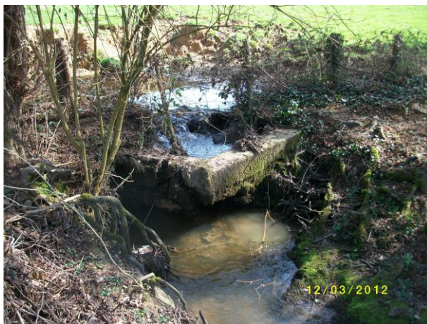
Ancien bac béton et berges piétinées avant travaux (source : SBV)
