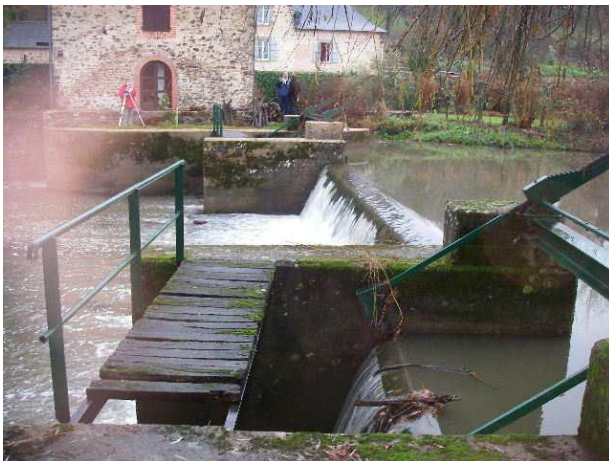
Clapets et déversoir avant travaux (source : SBV)
