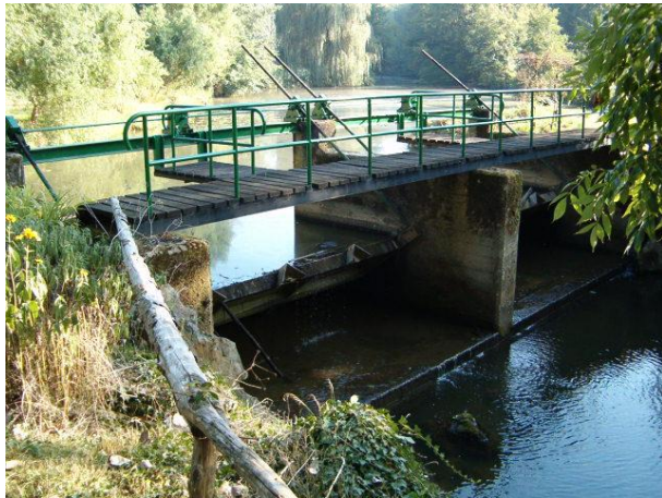
Clapets avant travaux
