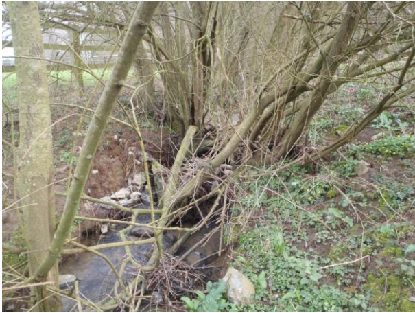
Branches en travers et embâcle obstruant le lit du ruisseau de l'Étang d'Olivet et pouvant limiter la libre circulation piscicole et sédimentaire
