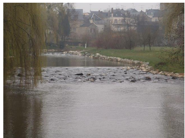
Seuil maçonné à la place du barrage après travaux (source : SBV)
