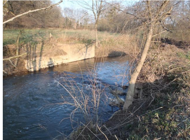
Site après travaux de démantèlement
