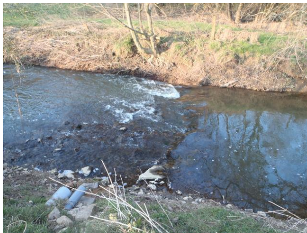
Mini-seuil aménagé sur le Vicoïn à l'amont du Painchaud au Genest-St-Isle favorisant la diversification des écoulements et l'oxygénation de l'eau.
