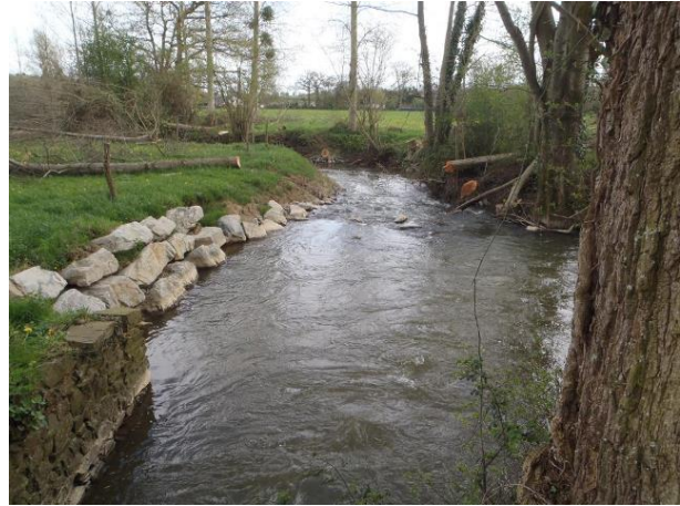
Renforcement des berges et seuil rustique après travaux
