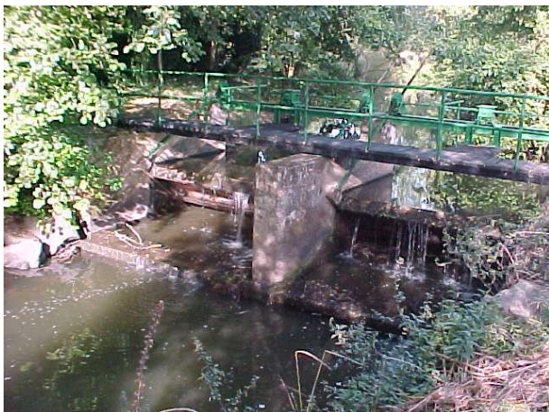
Clapets avant travaux
