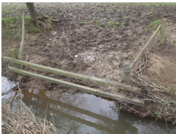
Abreuvoir en descente aménagée engendrant la formation d'embâcles sur le Vicoin à Bourgneuf-la-Forêt
