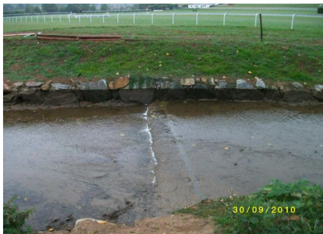
Vue des fondations et des rives du batardeau amovible (planches non montées) (source : SBV)
