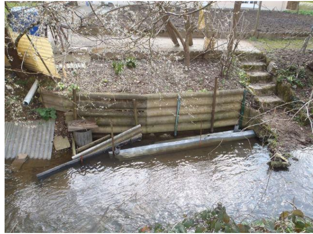
Protection artisanale de berge sur le ruisseau de la Grande Vacherie à Saint-Pierre-la-Cour
