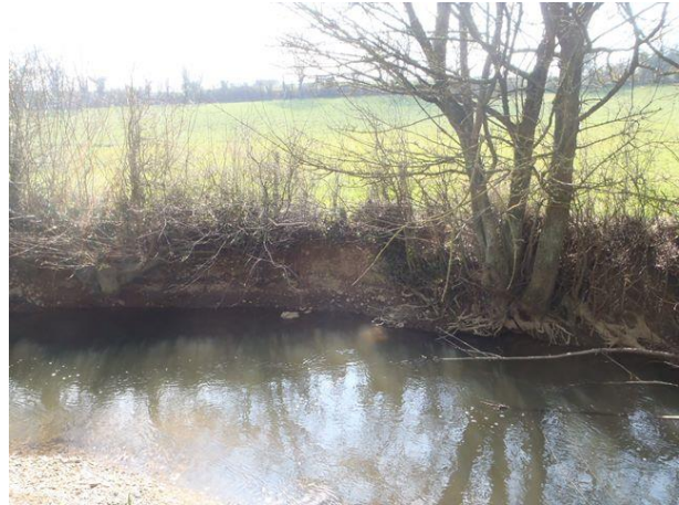
Erosion latérale de la berge en berge concave sur le Vicoin
