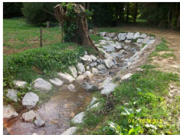
Vue du lit depuis l'amont après travaux de renaturation (source : SBV)
