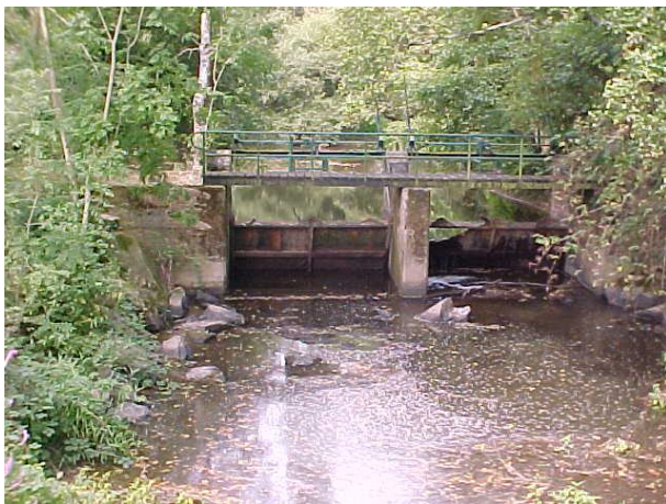
Clapets avant travaux
