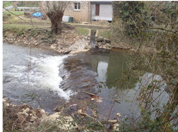
Seuil rustique à la place des clapets après travaux
