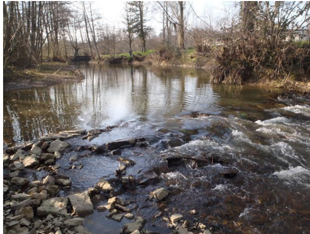
Mini-seuil aménagé sur le Vicoin permettant de garder une certaine lame d'eau pour les poissons et la pratique de la pêche à l'amont de l'ancien clapet du Pré Sec au Genest-St-Isle
