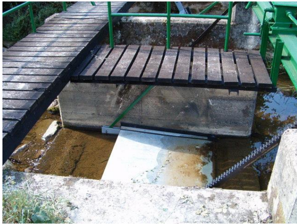
Clapets avant travaux
