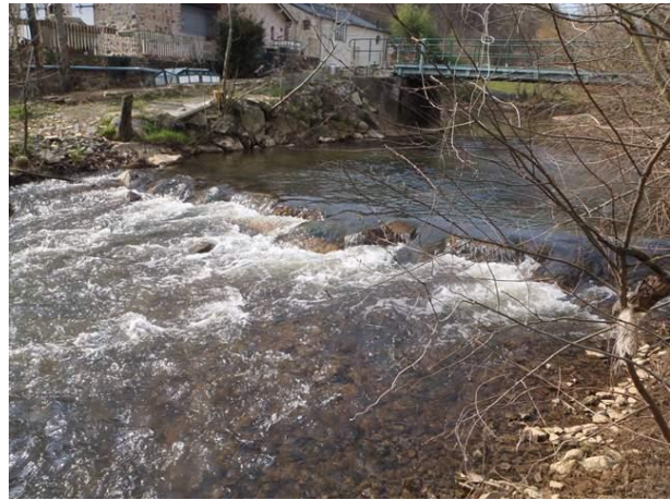
Recharge en bloc à l'aval des anciens clapets après travaux
