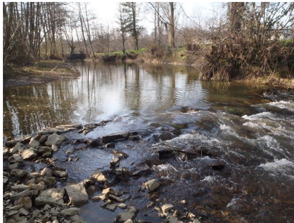
Mini-seuil aménagé sur le Vicoin calant la ligne d'eau sur plusieurs dizaines de mètres à l'amont près du bourg du Genest-St-Isle
