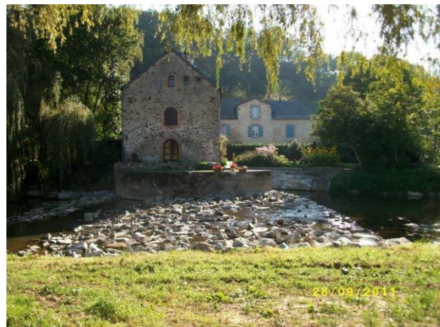
Seuil maçonné à la place du barrage après travaux (source : SBV)
