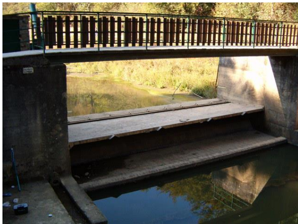
Clapet avant travaux
