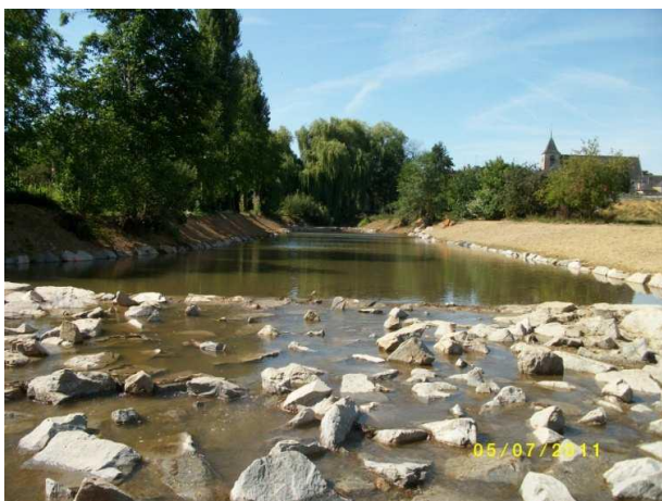
Vue de détail sur le seuil maçonné depuis l'aval après travaux. Vue de l'enrochement de pied de berge sur les deux rives. (source : SBV)
