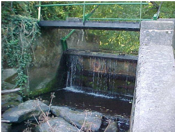
Clapet avant travaux
