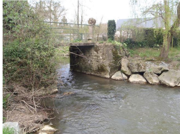
Site après travaux
