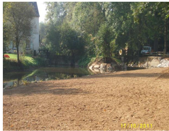
Berge après travaux, avec l'enrochement de protection en tête d'île. Le seuil maçonné cale une ligne d'eau alimentant le bief de moulin dès que Q rivière > DMR ( 0,2 \text{ m}^3/\text{s} ) (source : SBV)
