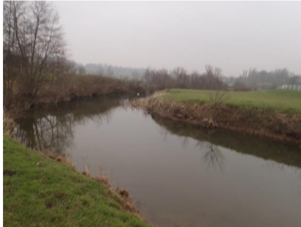
Maintien d'une zone d'influence de plusieurs centaines de mètres sur le Vicoïn en amont du seuil maçonné remplaçant le barrage du Moulin du bourg de Nuillé-sur-Vicoïn
