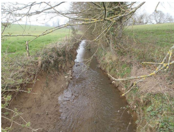
Lit recalibré sur le Vicoin (Port-Brillet)
