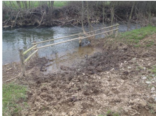
Berges fortement piétinées au niveau d'un abreuvoir aménagé sur le Vicoïn à Nuillé-sur-Vicoïn suite au départ du matelas caillouteux.
