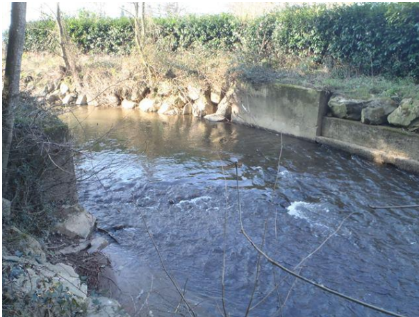
Ancien clapet des Buttes (STEP du Genest-St-Isle) sur le Vicoïn totalement franchissable car entièrement supprimé.
