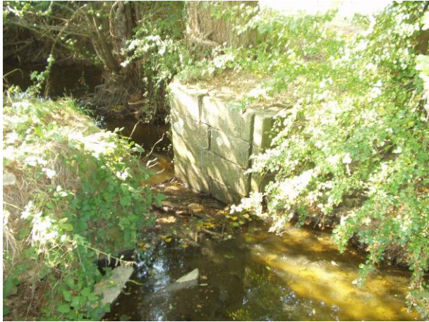
Culées et radier du batardeau avant travaux
