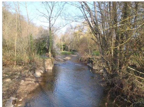
Site après travaux de démantèlement
