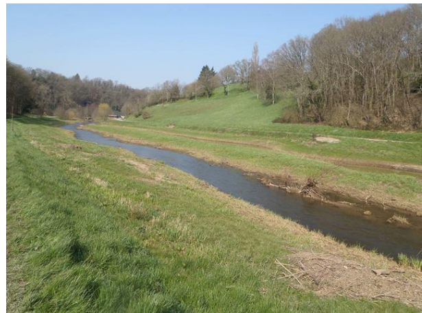
Vue de l'amont après travaux de démantèlement
