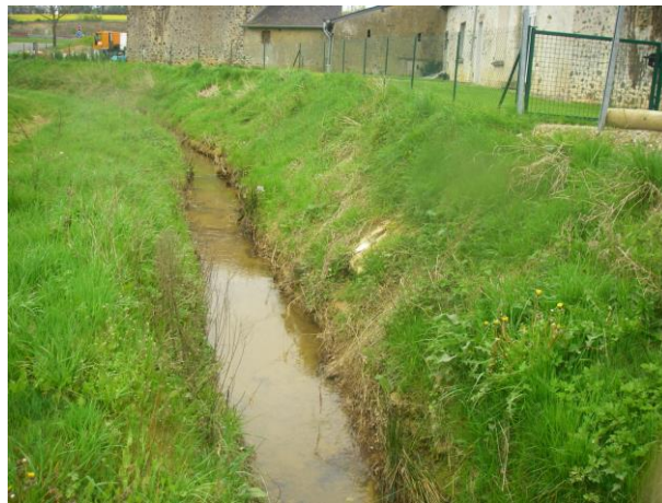
Recalibrage du lit et reprofilage des berges sur le ruisseau du Pont au Chat à Montigné-le-Brillant
