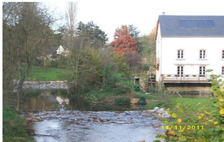
Vue depuis l'aval après travaux. Au premier plan, la recharge en blocs et granulats et, au second plan, le seuil maçonné (source : SBV)
