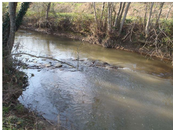
Mini-seuil aménagé en forme de déflecteur sur le Vicoin près du bourg du Genest-St-Isle
