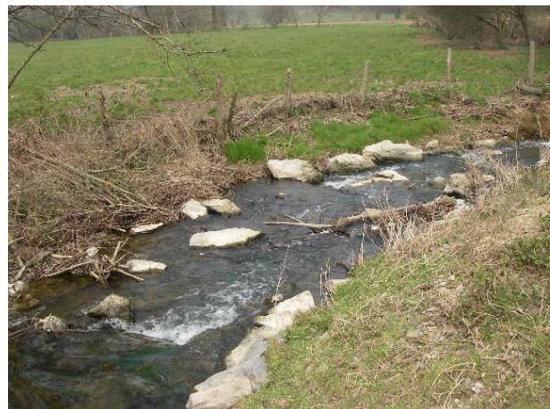
Seuil rustique en pierres après travaux
