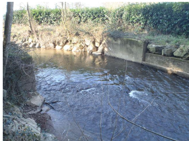
Site après travaux de démantèlement
