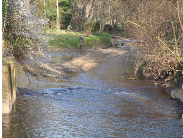
Le Vicoïn a retrouvé un fonctionnement naturel avec une forte diminution de l'envasement suite à la suppression du clapet du Moulin de Raffray (le Genest-St-Isle)
