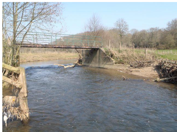
Site après travaux de démantèlement
