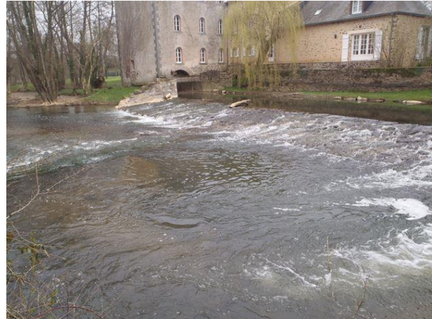
Après travaux d'écrêtement du déversoir
