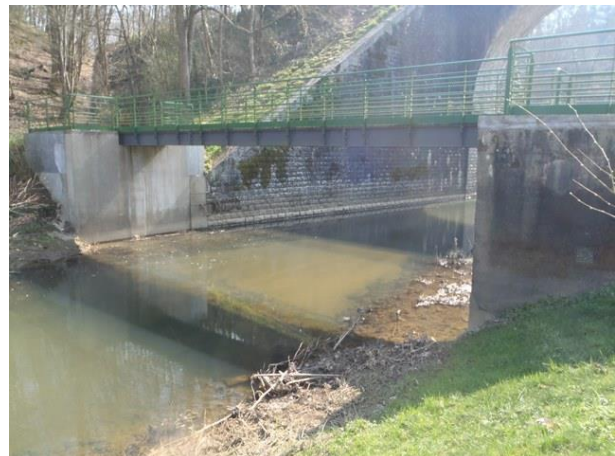
Site après travaux de démantèlement
