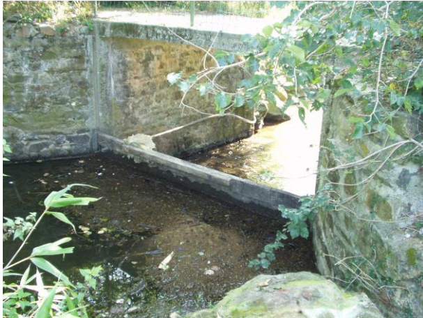
Batardeau avant travaux
