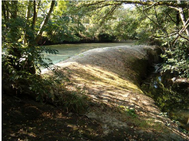
Déversoir avant travaux
