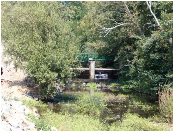
Clapets avant travaux
