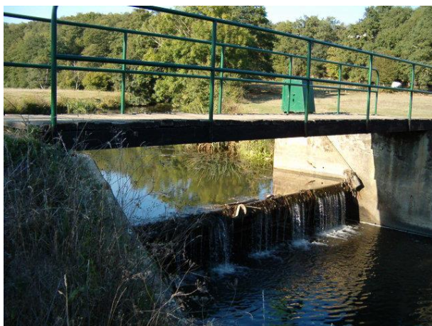
Clapet avant travaux
