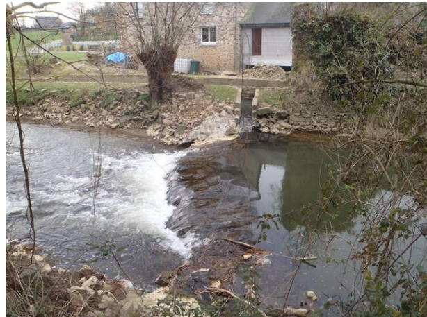
Ancien barrage du Moulin de la Roche sur le Vicoïn (Montigné-le-Brillant) conservant un problème de franchissement piscicole et d'élévation de la ligne d'eau à l'amont du fait de l'aménagement d'un seuil.
