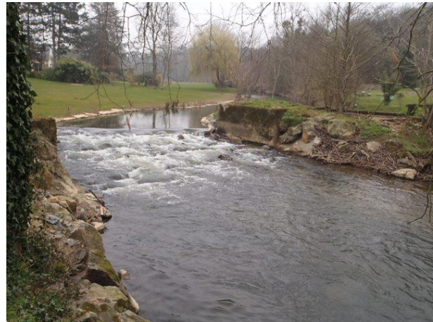
Seuil maçonné à la place des clapets après travaux
