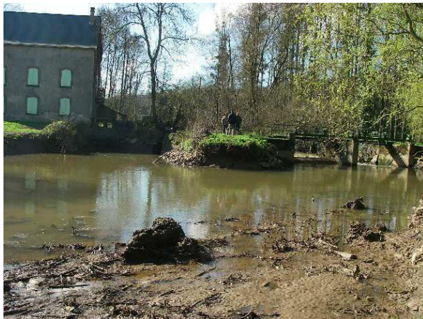
Vue depuis l'amont de la berge avant travaux et du dépôt vaseux en lit mineur au premier plan. Vue du bief à gauche de la photo, de l'île centrale érodée et du barrage à droite (source : SBV)
