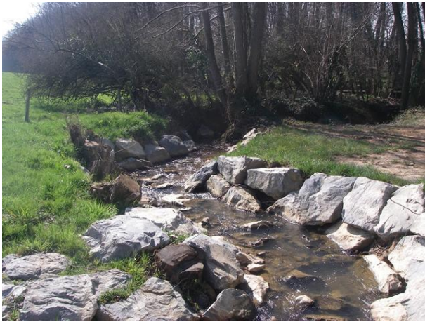
Protections de berges avec des blocs sur le ruisseau du Plessis au Genest-St-Isle
