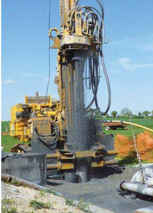
Le captage des eaux souterraines par forage pour l'alimentation en eau potable.
