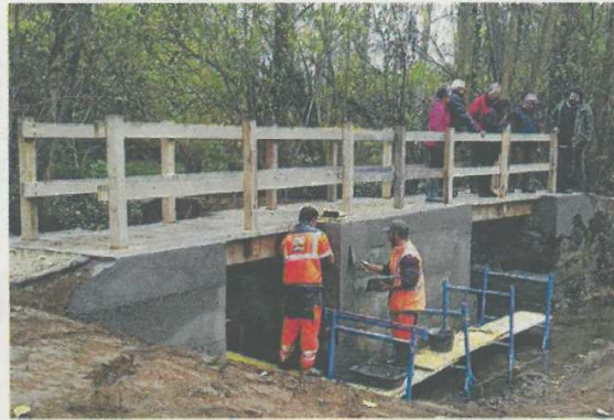
La nouvelle passerelle a demandé deux semaines de travaux.
