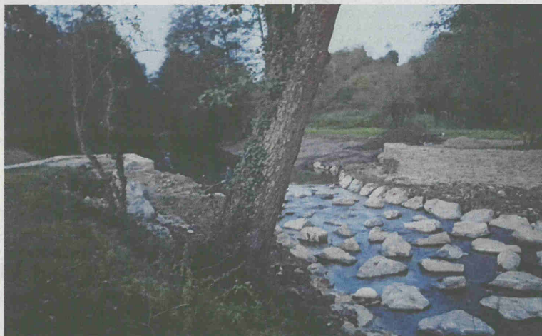
La suppression du barrage de la Roche-Brault à Sauges.
