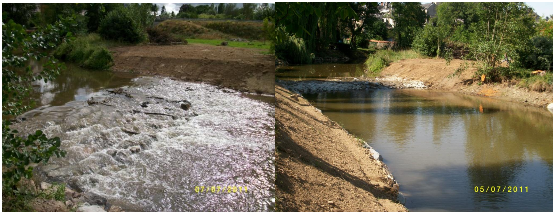
Figure 9 : Vue de détail du seuil rustique amont à gauche et vue du même seuil depuis l'aval à droite après travaux.
