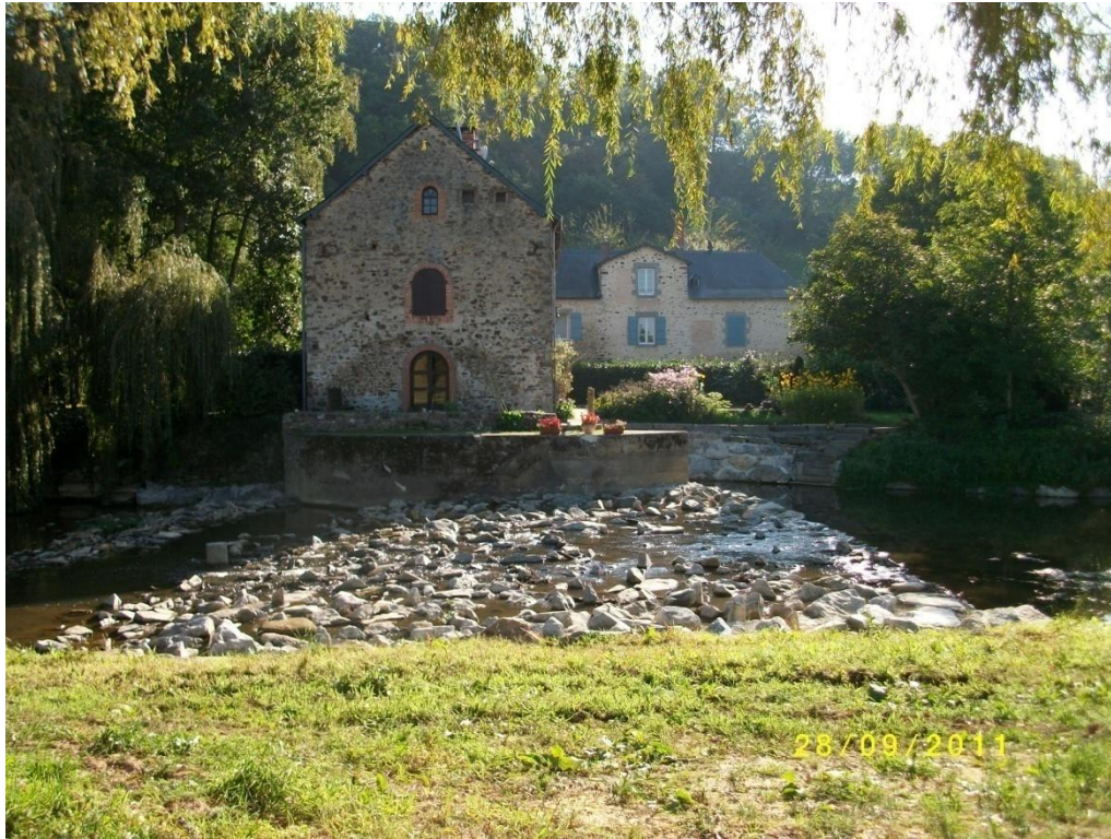
Figure 7. A gauche, vue du seuil maçonné sur l'emprise de l'ancien barrage depuis la rive gauche. Vue de détail sur le seuil maçonné à droite depuis l'aval du seuil. Vue de l'enrochement de pied de berge sur les deux rives.
