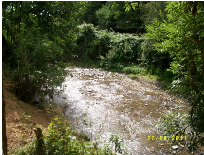
Figure 13 : recharge en place après travaux dans le lit mineur an amont de La Roche à Nuillé.
