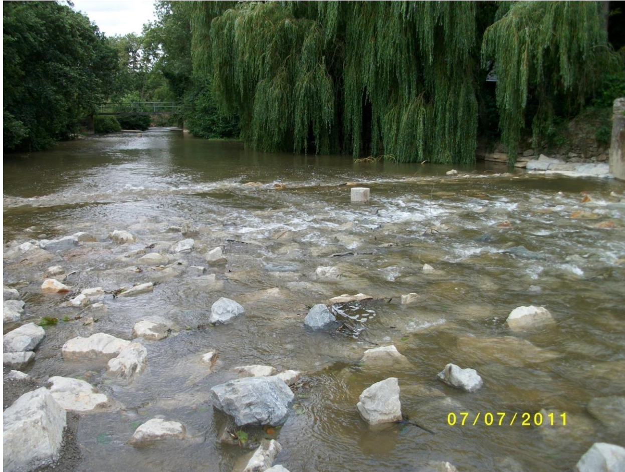
Figure 8 : Vue de détail du seuil maçonné depuis l'amont. Noter au second plan le seuil aval de l'ouvrage et le déflecteur de sortie de bief (à droite de l'image)
