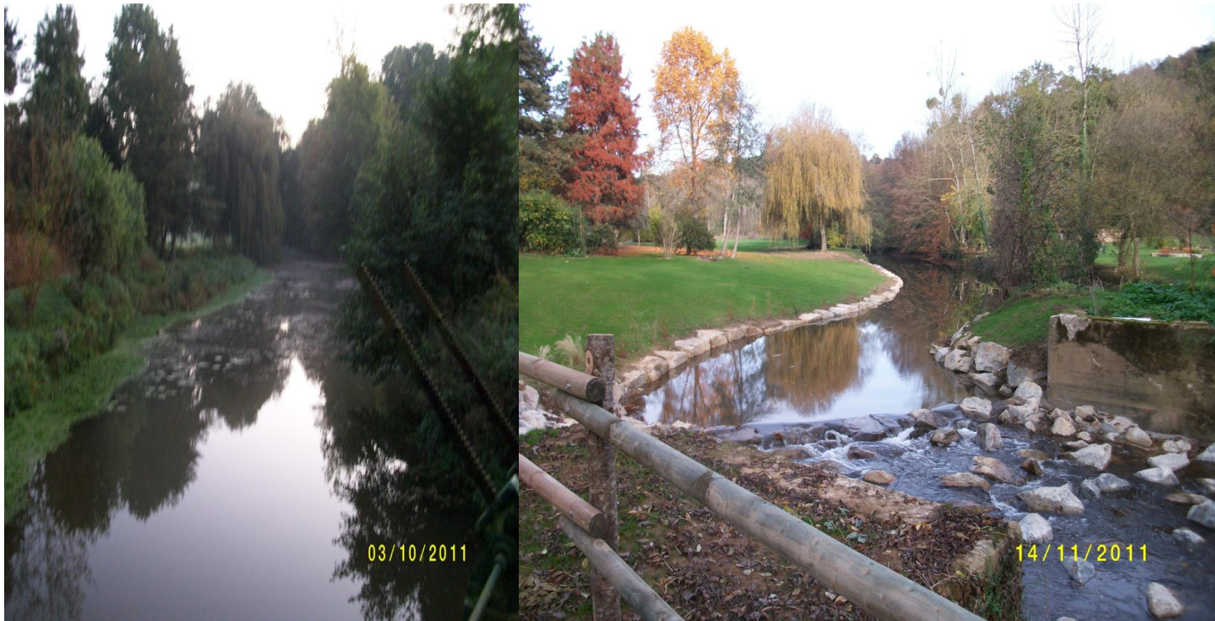
Figure 2 : vue depuis l'aval de la berge avant travaux (à g). Vue (à d) du seuil rustique maçonné et de la berge retalutée et de son pied en enrochement après travaux. Au premier plan, la rambarde de sécurité en sommet de la culée rive droite.
