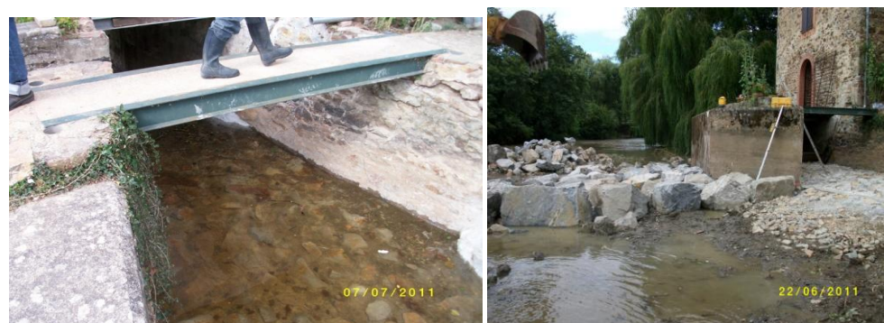
Figure 10 : Vue du radier béton de fond de bief à gauche et vue à sec (pendant travaux) de ce radier.
