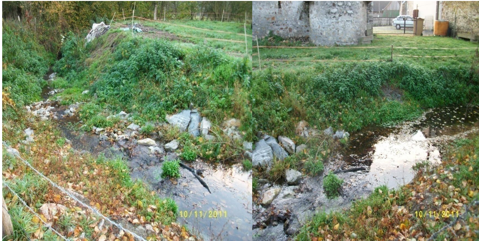
Figure 12. Vue des travaux réalisés. Le seuil béton a été retiré et remplacé par un seuil en pierre rustique de 6 m de long et de dénivelé 30 cm.
