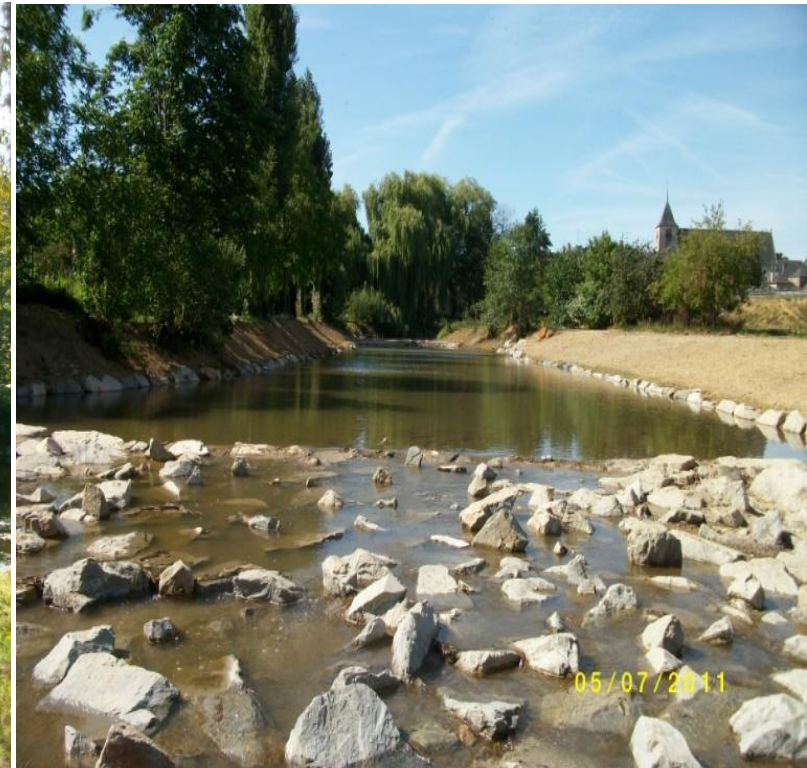
Figure 7. A gauche, vue du seuil maçonné sur l'emprise de l'ancien barrage depuis la rive gauche. Vue de détail sur le seuil maçonné à droite depuis l'aval du seuil. Vue de l'enrochement de pied de berge sur les deux rives.
