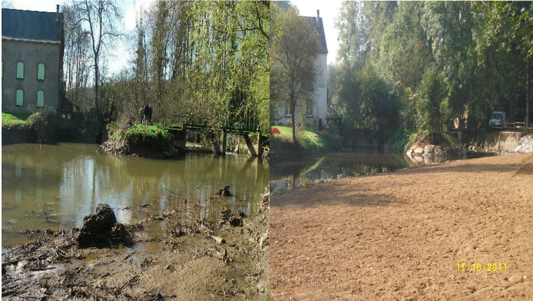
Figure 3 : A gauche, vue depuis l'amont de la berge avant travaux et du dépôt vaseux en lit mineur au premier plan. Vue du bief à gauche de la photo, de l'île centrale érodée et du barrage à droite. Vue de droite : berge après travaux, noter l'enrochement de protection en tête d'île. Le seuil rustique cale une ligne d'eau alimentant le bief de moulin dès que Q_{\text{rivière}} > \text{DMR} (0,2 m 3 /s).
