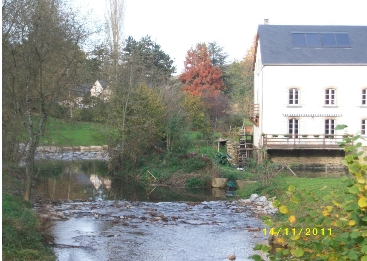
Figure 4 : Vue depuis l'aval du moulin de Thuboeuf (à d.). Au premier plan la recharge en blocs et granulats et, au second plan, le seuil maçonné.
