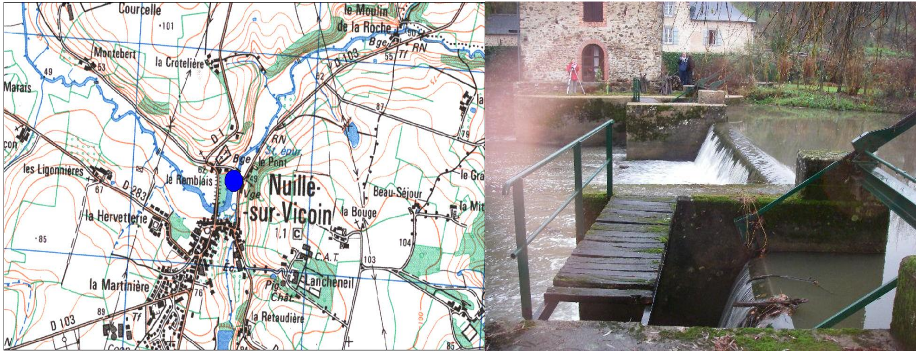
Figure 6. Localisation du site et vue de l'ancien barrage depuis la rive gauche.
