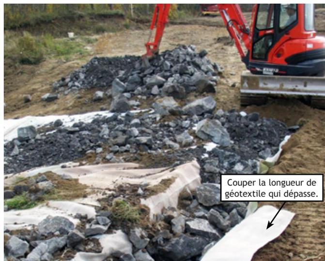
Photo 8 : Clé d'ancrage du tablier d'entrée
