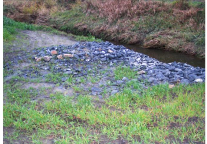
Photo 4 : Tablier d'entrée d'un déversoir enroché
