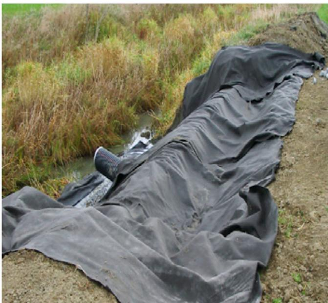
Photo 9 : Pose du géotextile
